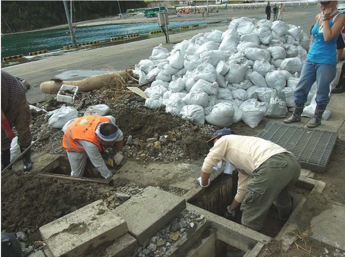
Die Arbeit hier war schwierig und mühselig, da die Abwasserkanäle mit nassem Schlamm verstopft waren und nach dem Ausheben des Schlammes gleich Wasser nachlief.
